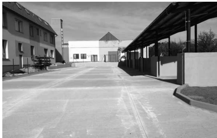
Výstavba nového sběrného dvora. Foto: Archiv OÚ Hrdějovice.
